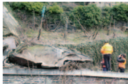
Рис. 2. Обрушившийся обломок скалы у портала тоннеля Лорелей
