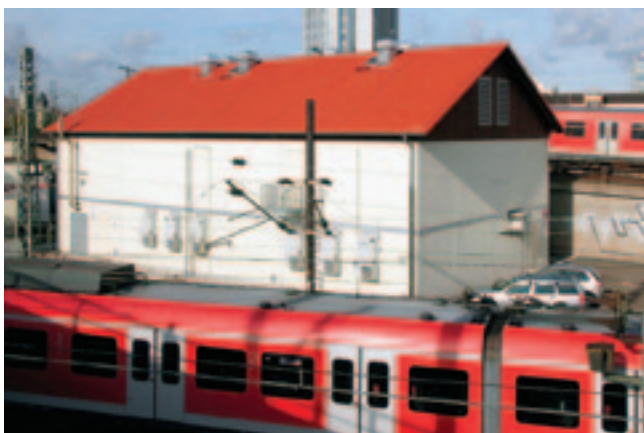
Рис. 3. Здание поста микропроцессорной централизации
