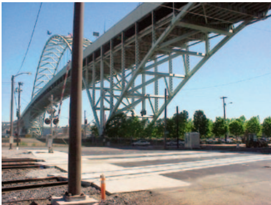
Рис. 3. Переезд, оснащенный покрытием корпорации Omega Industries
