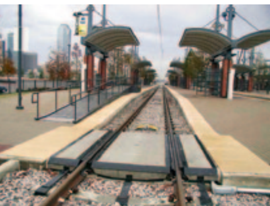
Рис. 2. Покрытие корпорации Century Group на пешеходном переходе
