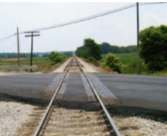
Рис. 6. Переезд с покрытием, включающим деревянные элементы корпорации Burke-Parsons-Bowlby
