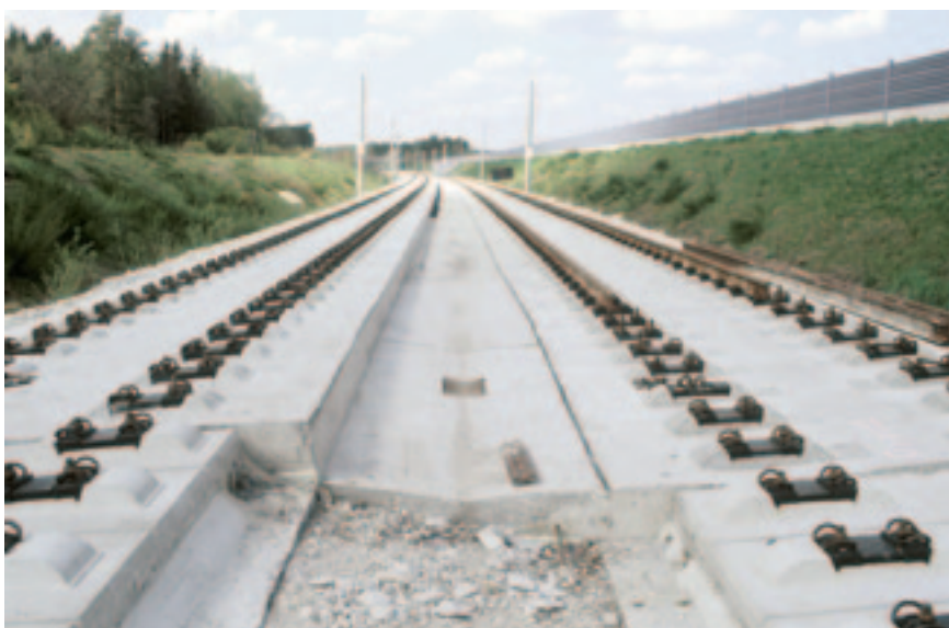
Рис. 3. Путь на плитном основании на линии Нюрнберг — Ингольштадт: на переднем плане — новая система Bögl на готовых несущих плитах; на заднем плане — путь системы Rheda 2000 (фото: DBAG, Вебер)
