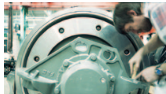
Рис. 2. Точная юстировка корпуса буксового подшипника (фото: Siemens)
