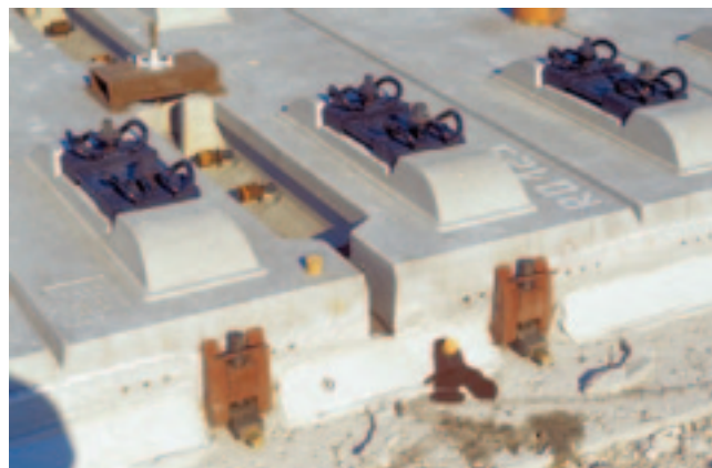
Рис. 3. Широкий стык между плитами со стяжными муфтами (фото: DBAG, Вебер)
