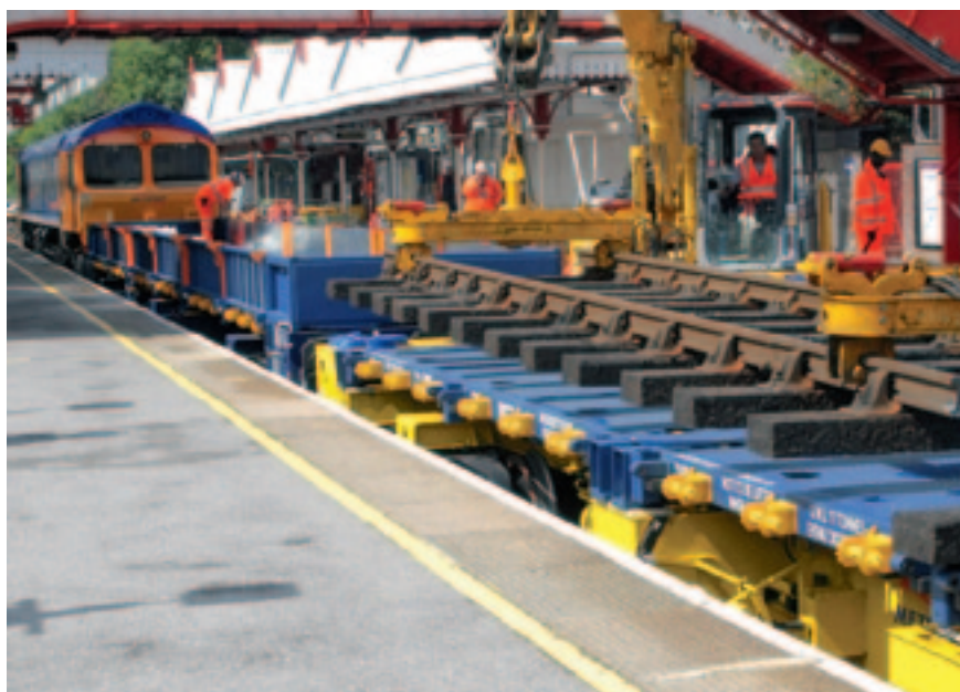
Рис. 4. Путьекладочный поезд Slinger на работах по реконструкции пути
