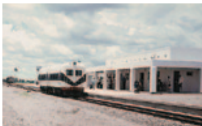
Рис. 2. Рельсовый автобус железных дорог Малави. Железные дороги Мозамбика, Малави и Замбии планируют реконструировать так называемый коридор Nacala в расчете на массовые перевозки угля на экспорт
