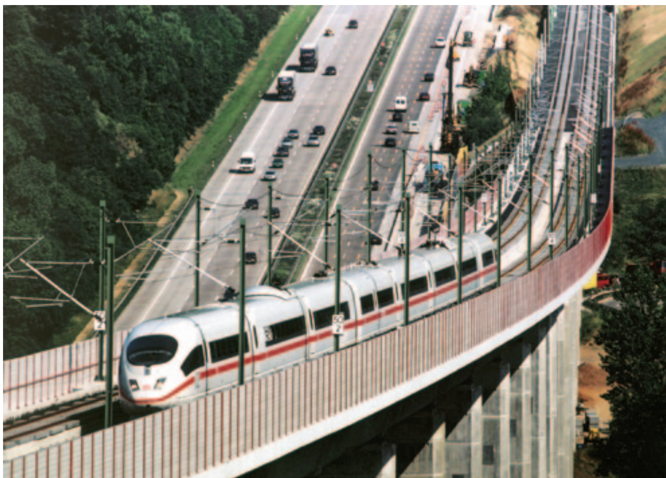
Рис. 4. Высокоскоростной электропоезд ICE3 на Халлербахтальском мосту линии Кёльн — Франкфурт-на-Майне (фото: DBAG, Мюллер)
