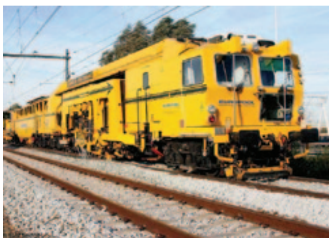
Рис. 2. Путевые работы на железных дорогах Нидерландов
