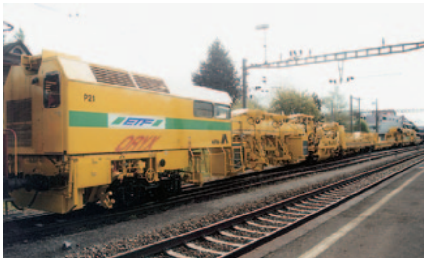
Рис. 3. Поезд P21 компании Matisa для ремонта и обновления пути
