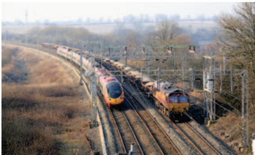
Рис. 3. Реконструированный участок магистрали Западного побережья
