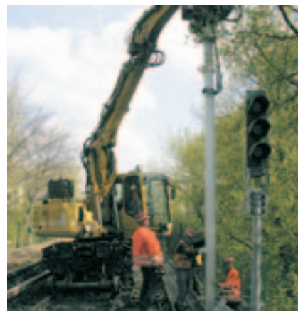
Рис. 5. Строительные работы с полным закрытием участка
