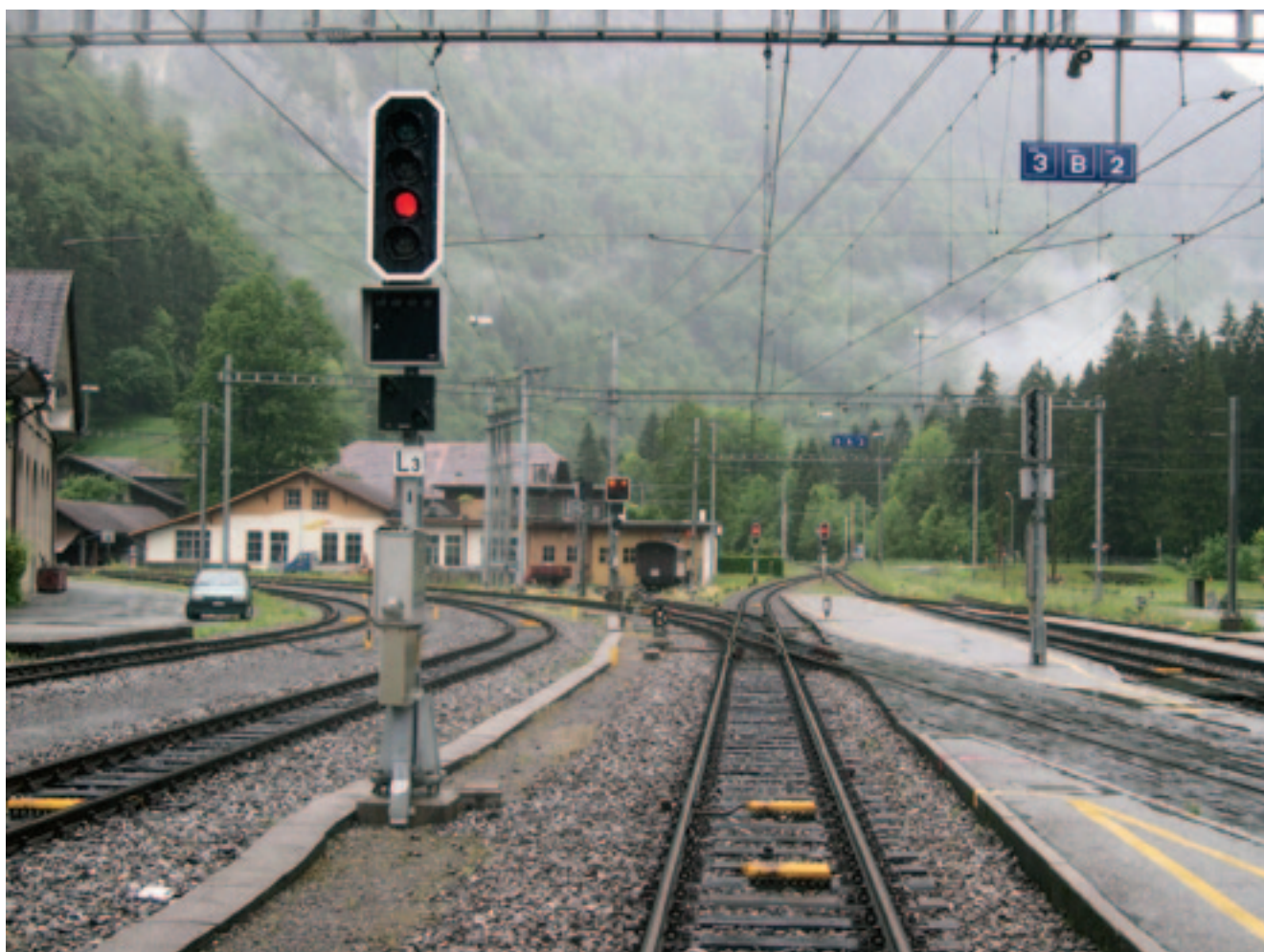
Рис. 2. Путевые приемопередатчики системы ZSI 127 на участке Интерлакен-Восточный — Цвайлүчинен железной дороги Berner Oberland-Bahnen (BOB) (фото: obs/Berner Oberland-Bahnen)
