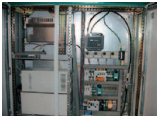
Рис. 5. Устройство сети WLAN, рассчитанное на наружную установку
