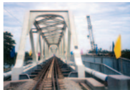
Рис. 2. Реконструкция одного из мостов
